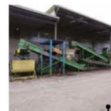
Impianti di frantumazione lavorazione del rifiuto
