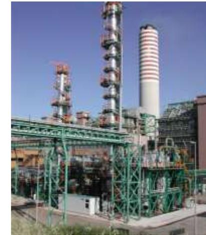
A Brindisi, presso la centrale Federico II è stato realizzato un pilota industriale da 10.000 Nm<sup>3</sup>/hr, per testare le effettive prestazioni della tecnologia su una scala significativa : efficienza, consumo energetico, sottoprodotti di reazione, emissioni
